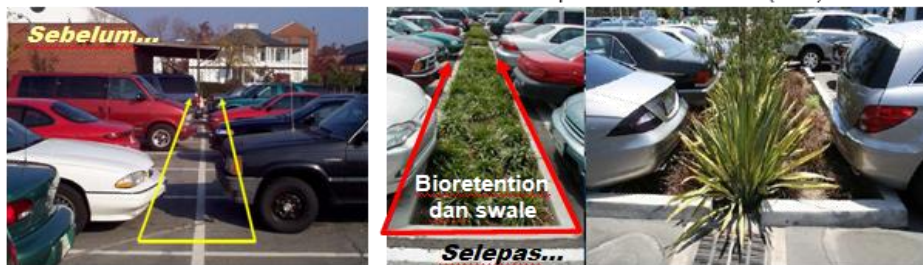
Bioretention di sepanjang sisi jalan
